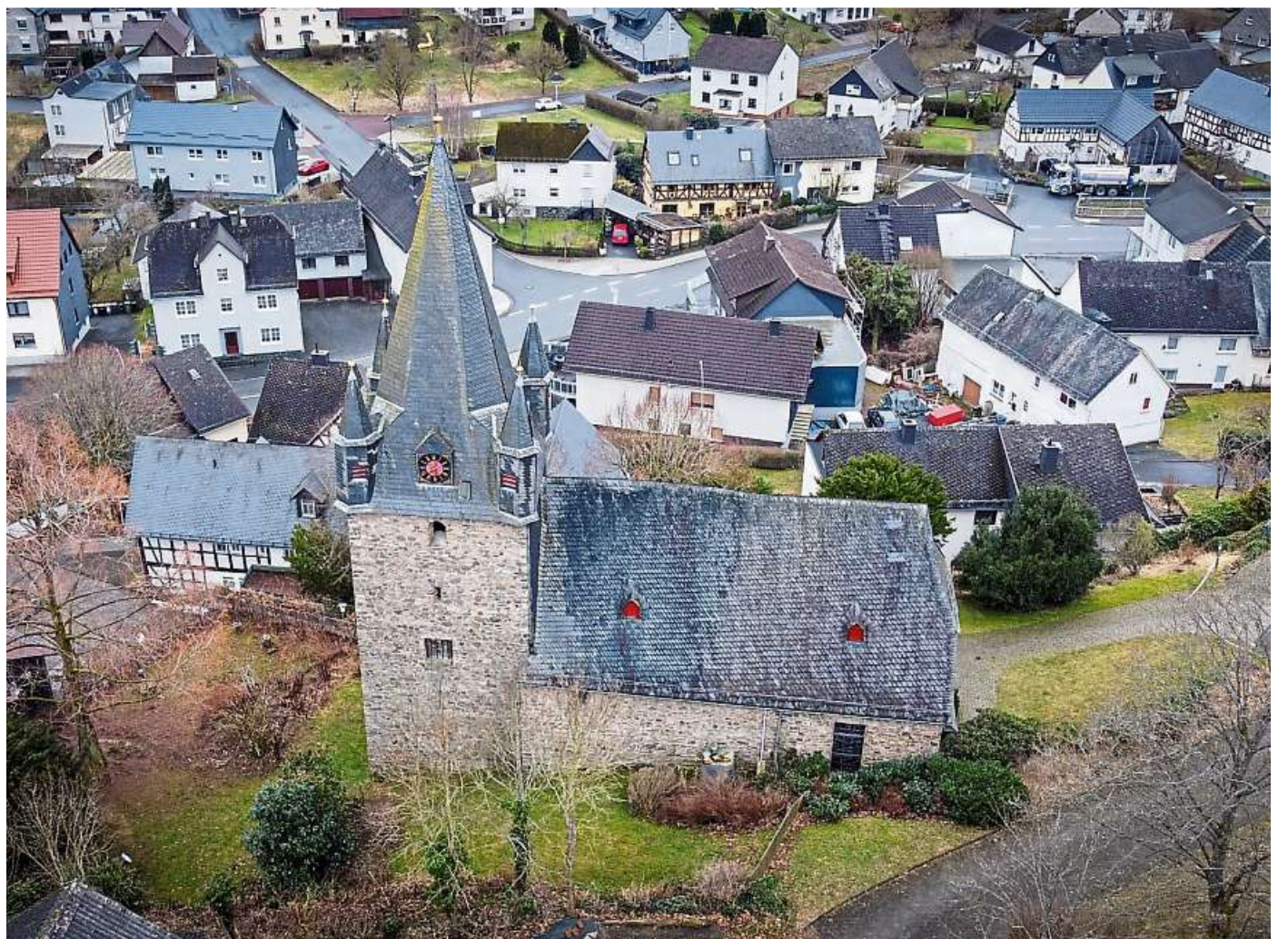
Das Dach der Lixfelder Kirche muss saniert werden. Die Kosten belaufen sich auf mehr als eine Million Euro.
